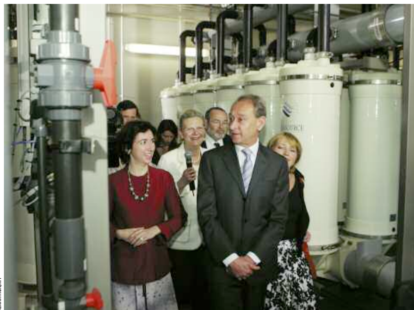
Bertrand Delanoë visite en avril 2007 la nouvelle usine d'affinage des eaux de l'aqueduc de l'Avre à Saint-Cloud.
